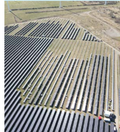
Während des Umbaus
